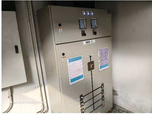
ชุดตัดกระแสไฟของอาคาร
