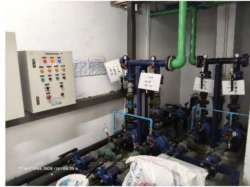
ปั๊มสูบน้ำใช้ไปยังถังเก็บน้ำดาดฟ้า
