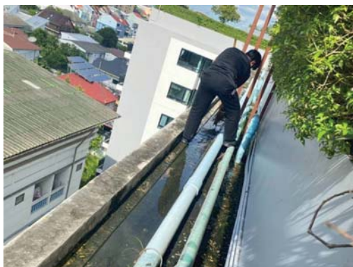
รางทำความสะอาดรางระบายน้ำฝน
