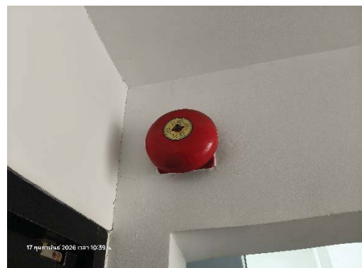
อุปกรณ์ส่งสัญญาณเตือนไฟไหม้ (Alarm Bell)
