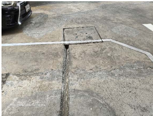
รางระบายน้ำฝนและบ่อพักน้ำรอบอาคาร
