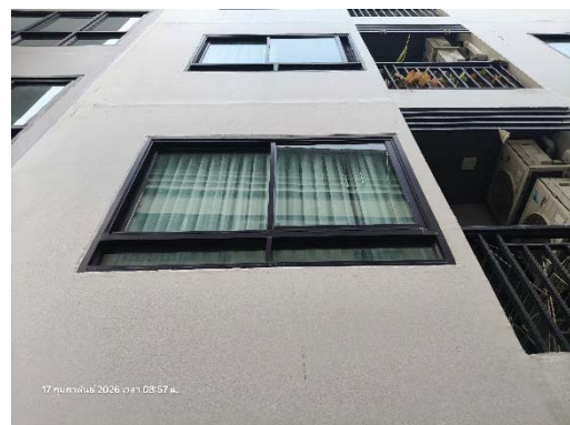
มีการติดตั้งกระจก ฝ้าผ่านลดความร้อนเข้ามาในอาคาร
