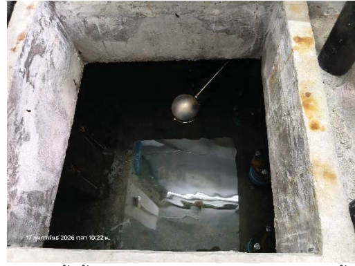
ถังเก็บน้ำชั้นใต้ดินโดยมีลูกลอยเป็นตัวควบคุมน้ำ
