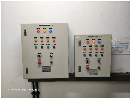
ตู้ควบคุมการทำงานของระบบบำบัดน้ำเสีย
